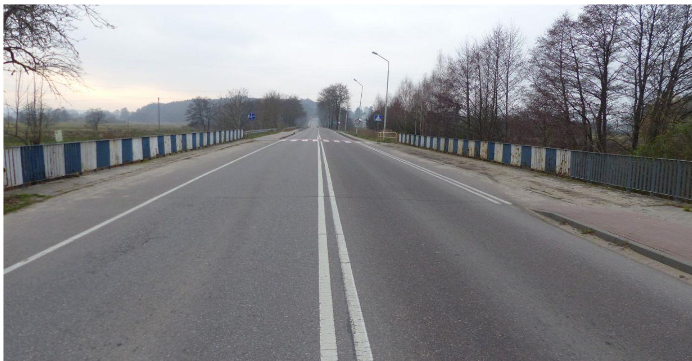
Fot. 3 Widok mostu z góry
