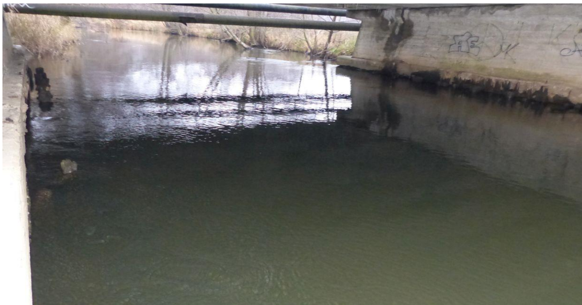
Fot. 32 Koryto rzeki, przestrzeń podmostowa
