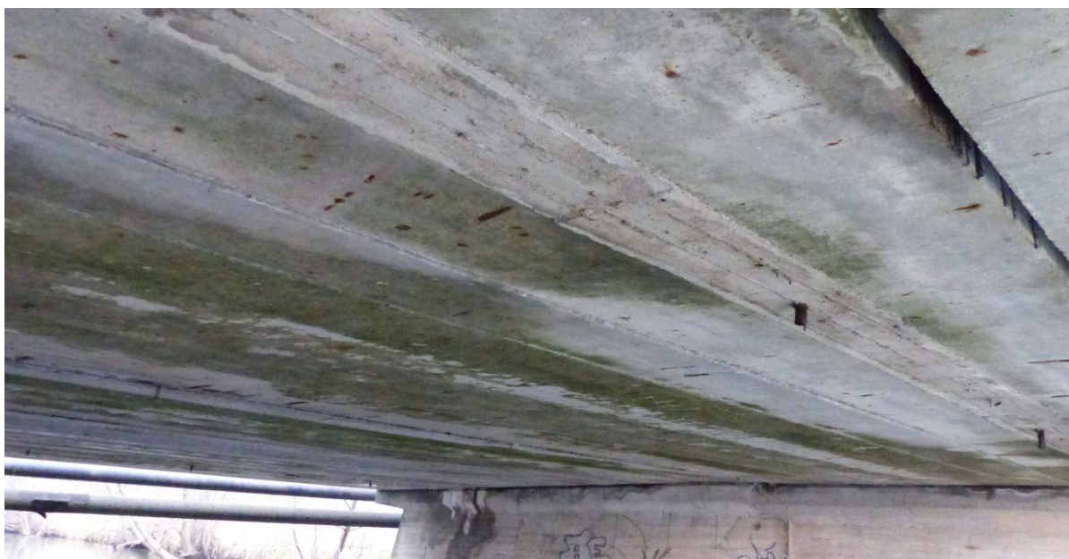
Fot. 23 Konstrukcja pomostu
