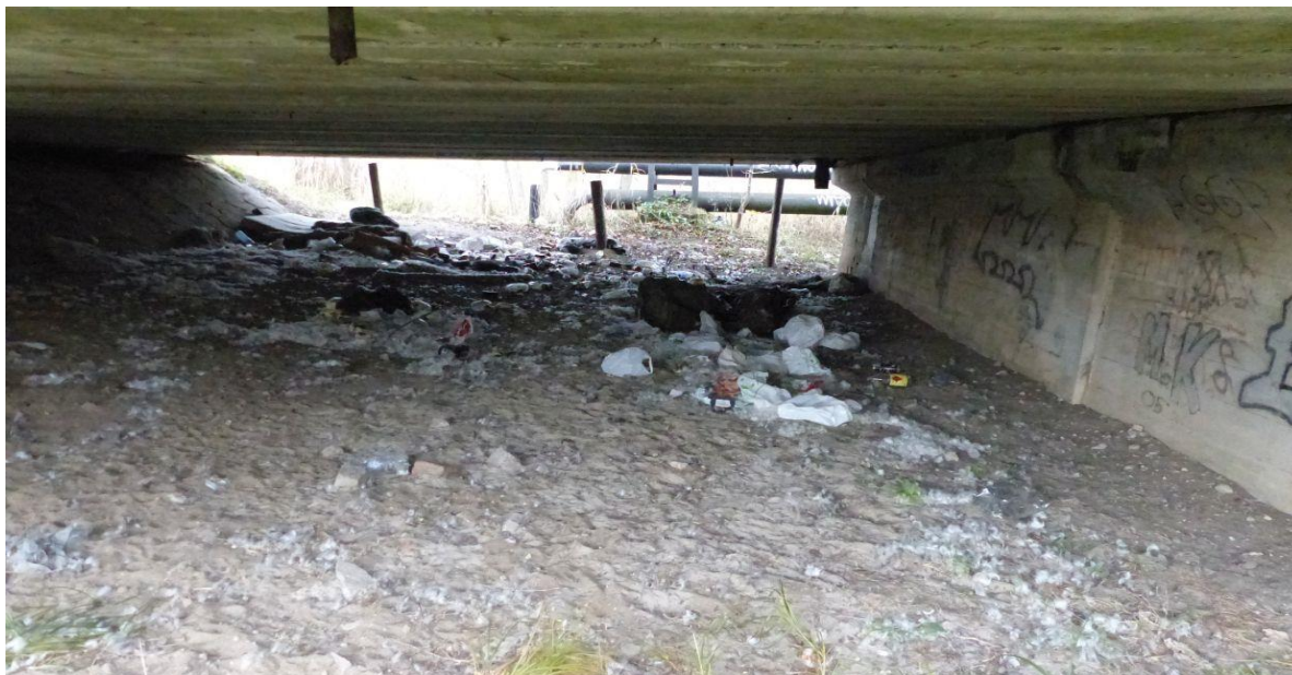
Fot. 31 Koryto rzeki, przestrzeń podmostowa
