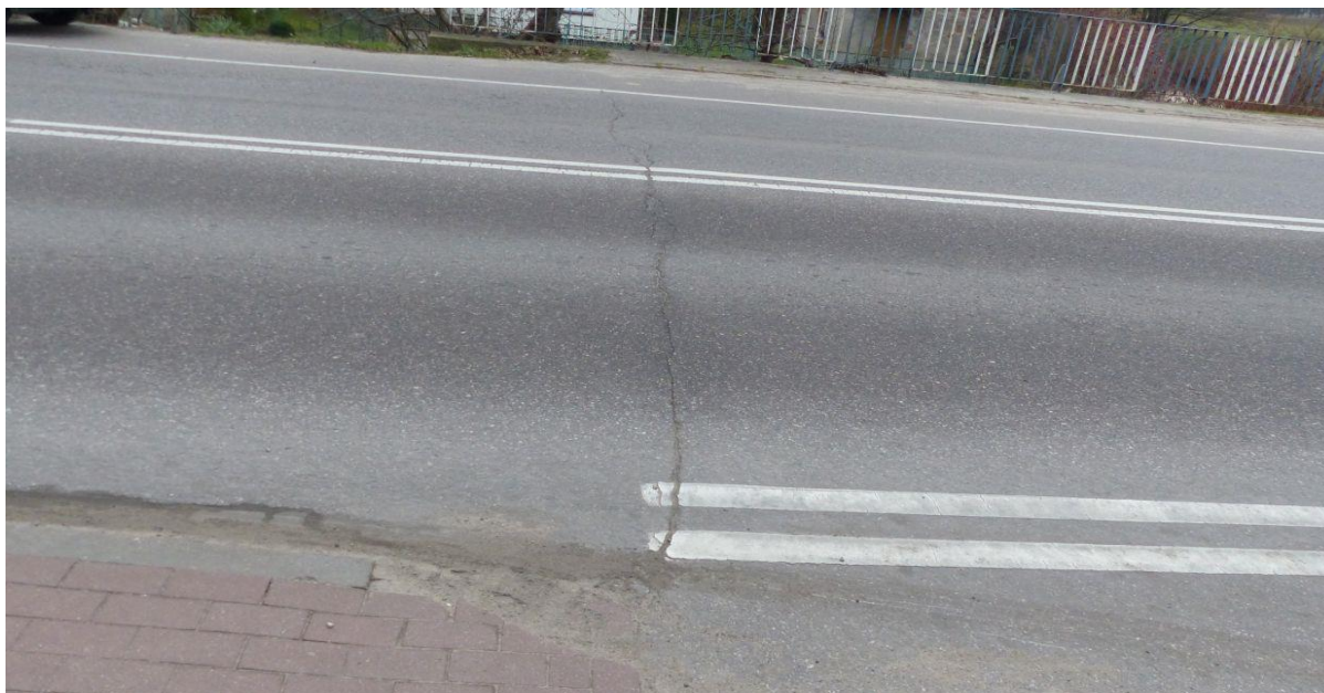
Fot. 26 Urządzenia dylatacyjne
