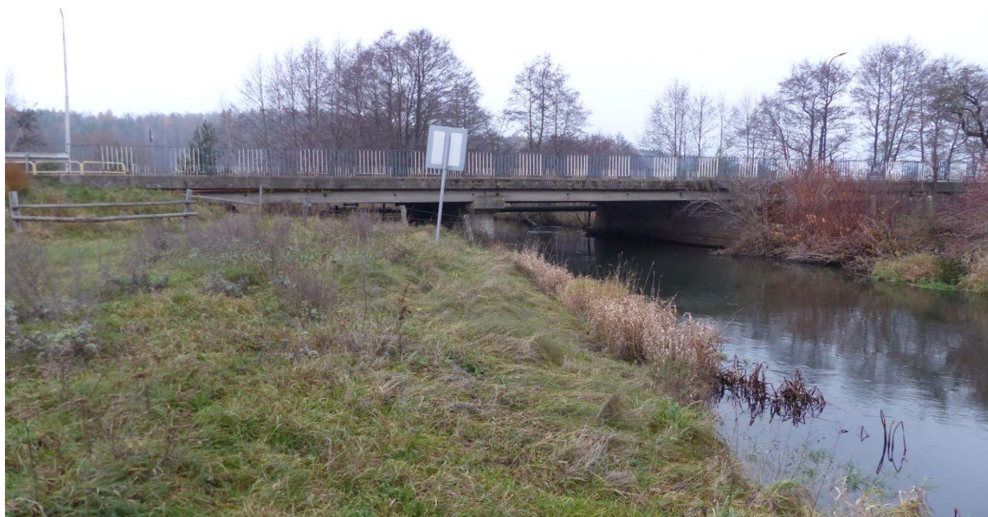
Fot. 4 Widok mostu z boku
