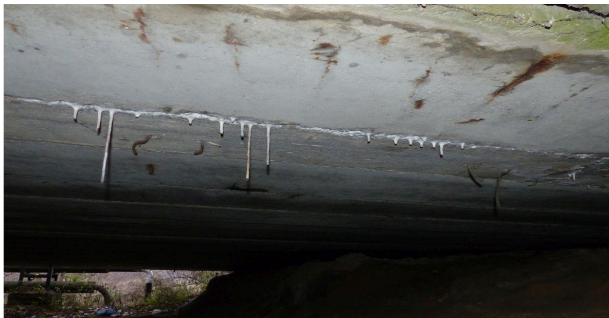
Fot. 22 Izolacja pomostu
