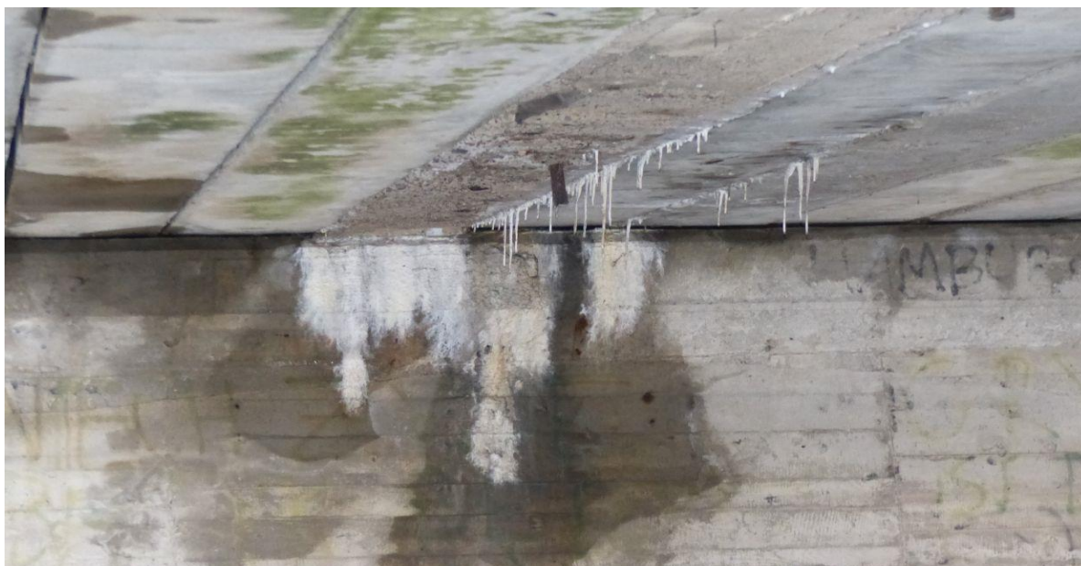
Fot. 24 Konstrukcja dźwigarów głównych
