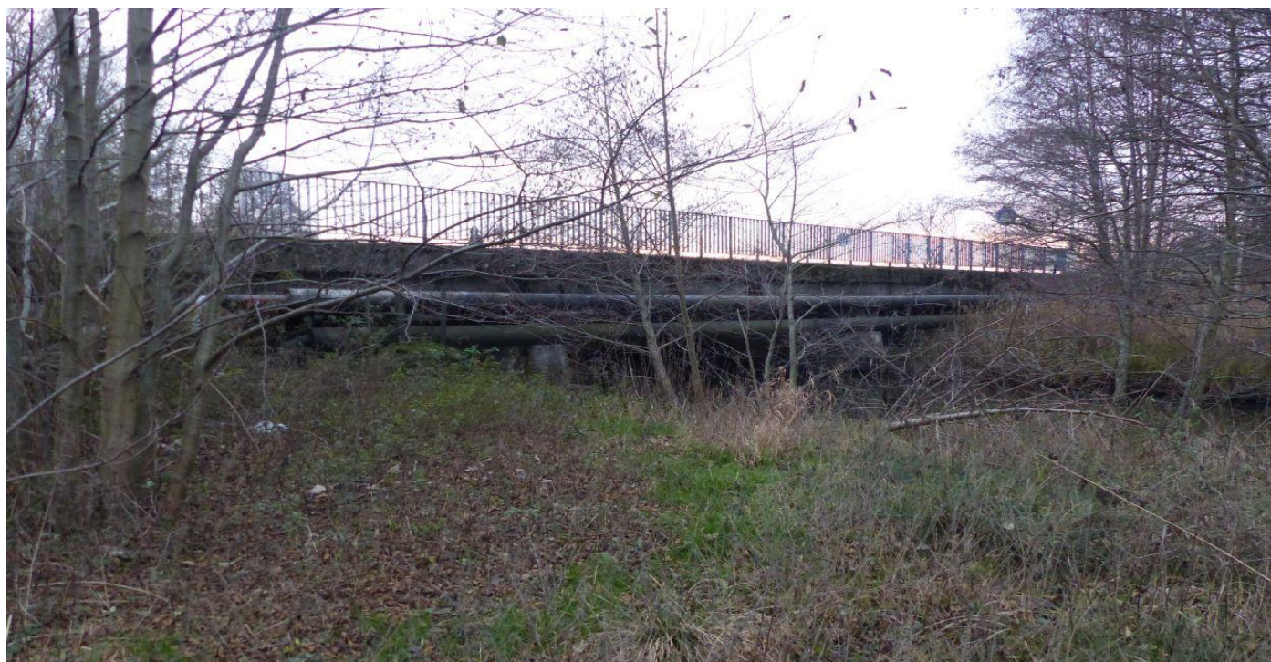
Fot. 5 Widok mostu z boku
