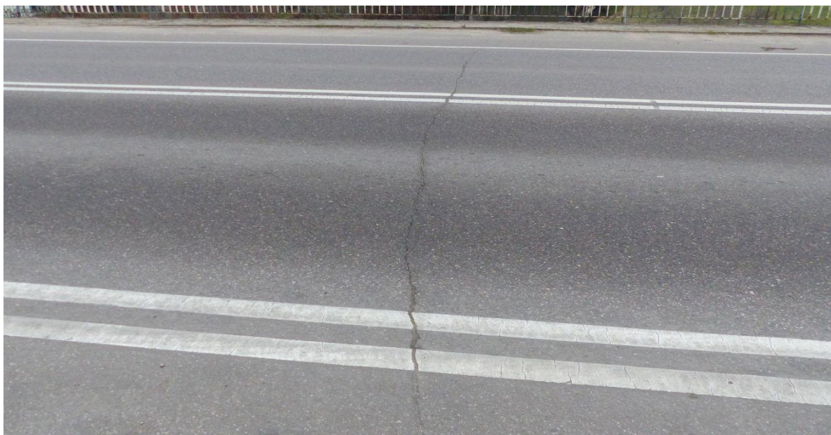
Fot. 27 Urządzenia dylatacyjne
